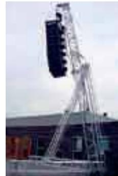
**PA-Tower kommen im Indoor- und Outdoorbereich** zum Einsatz; wobei für beide Fälle in der Regel nicht die Höhe der vertikalen Nutzlast das begrenzen Argument ist, sondern die anzusetzenden Horizontallasten.
